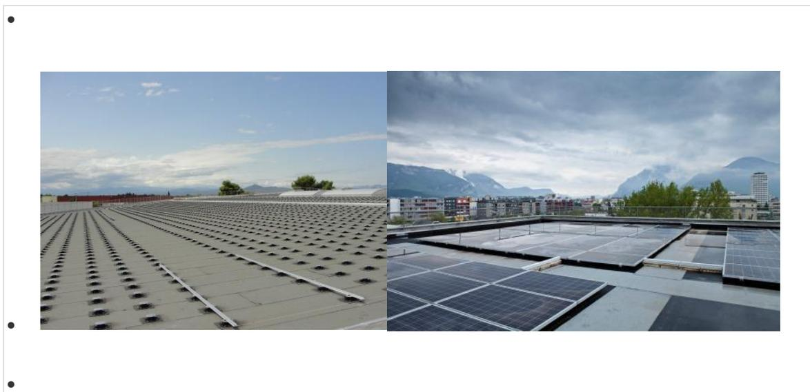
**SOPRASOLAR FIX ALU** est un système d'étanchéité photovoltaïque dédié à l'intégration de module rigide (cristallin) sur toiture terrasse.
