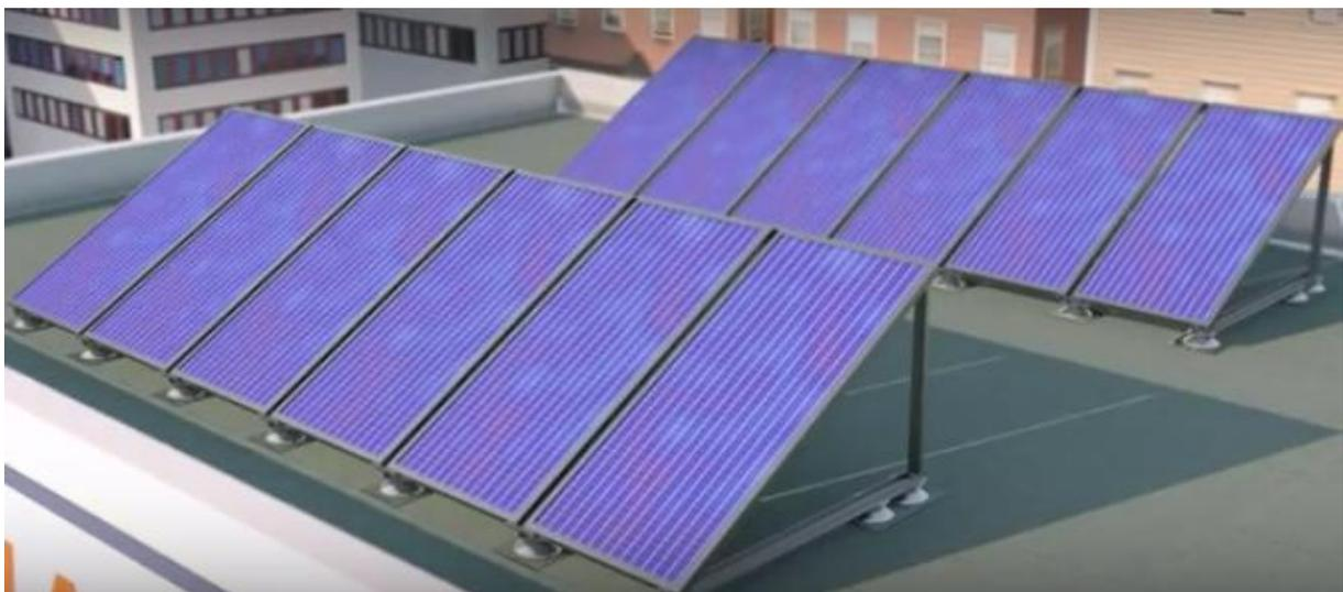
Cependant comme vous pouvez le noter grâce à l'ombre des panneaux au sol, on a un grand déchet en surface : le second rang de panneaux doit être au moins à  $2.5 \times$  Distance d'élévation (verticale). Le
